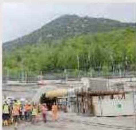
Cantiere di Chiomonte
